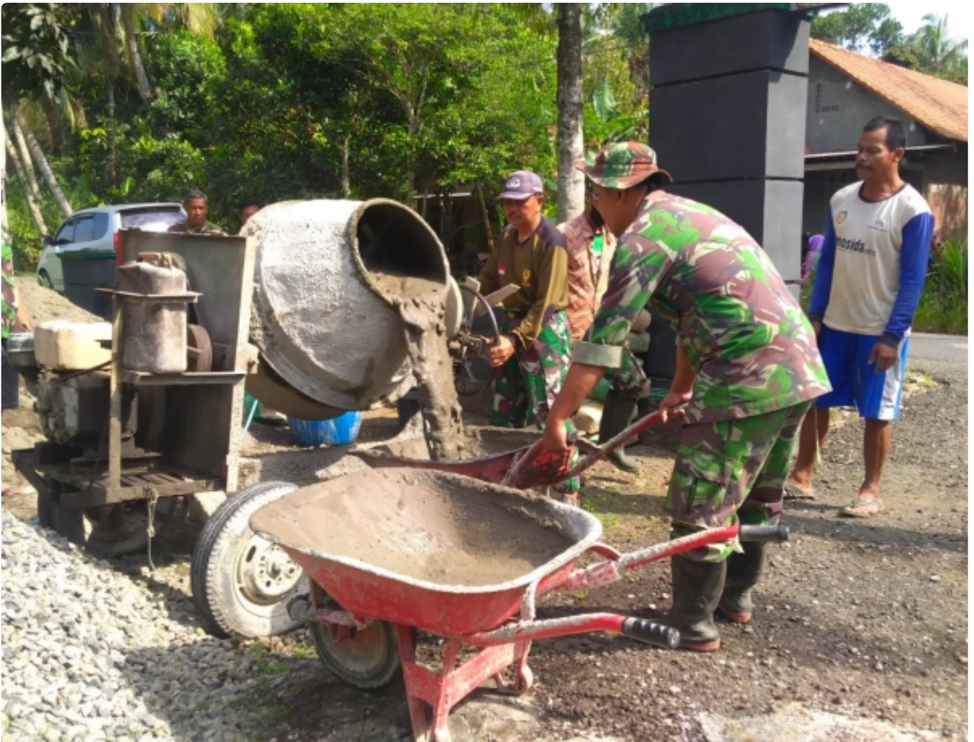
Anggota Posramil Bonorowo Bantu Warga Pengecoran Jalan
